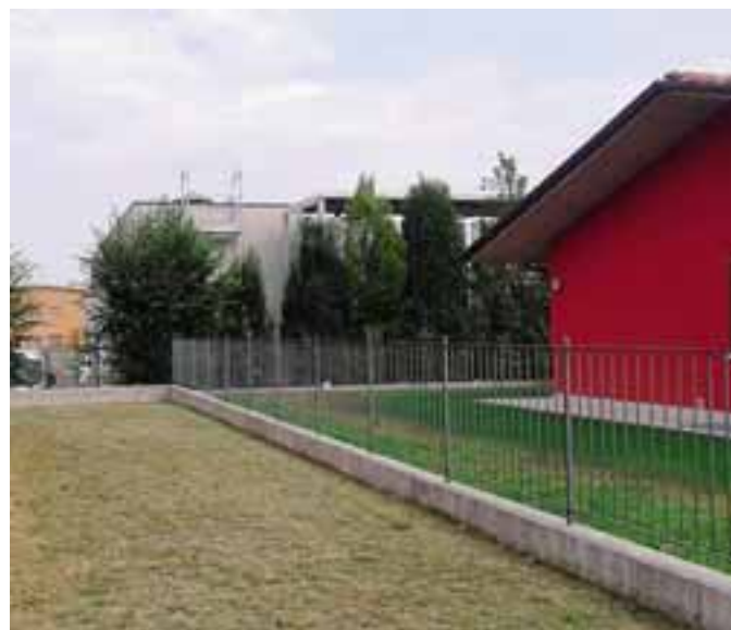
Scorcio d'archivio dell'impianto a biomassa in realizzazione in via Volta
