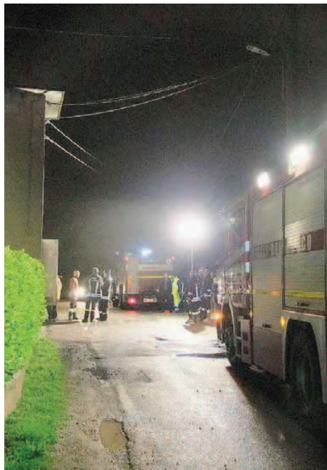
Via XXV Aprile a Filago, dov'è bruciata la cabina Enel causando il black out
