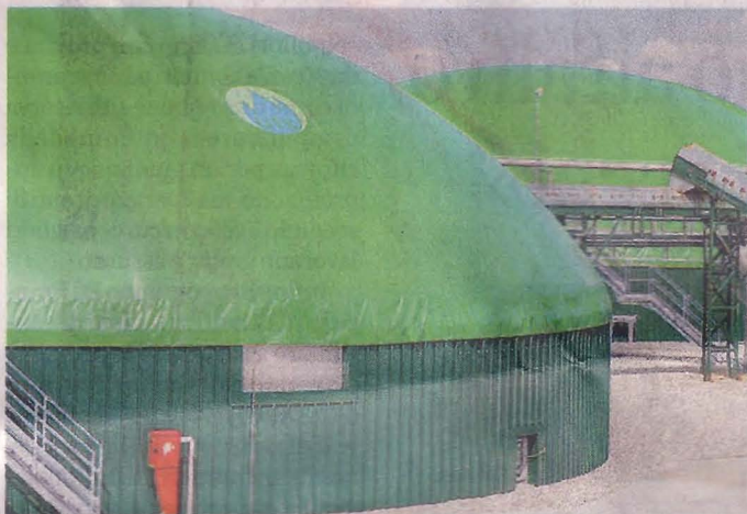
L'impianto a biogas a Malpaga
