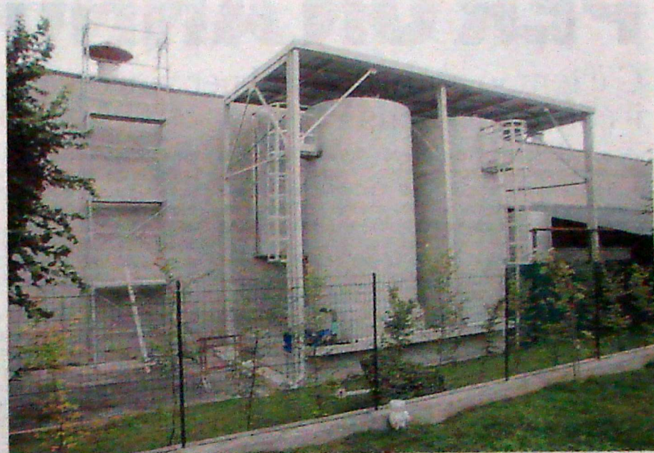
La bio-centrale a olio vegetale si trova in via Volta a Cavernago
