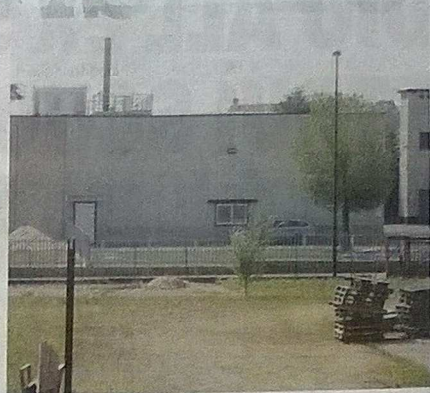
CENTRALE L'impianto a olio vegetale di via Volta è famoso per le fumatine nere e per il rumore. A destra, i pannelli isolanti installati recentemente, che hanno già dato, però, qualche «problema»
